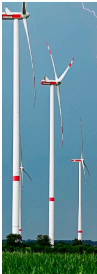
Über den Bau weiterer Windenergieanlagen ist in Nottuln eine intensive Debatte entbrannt.
