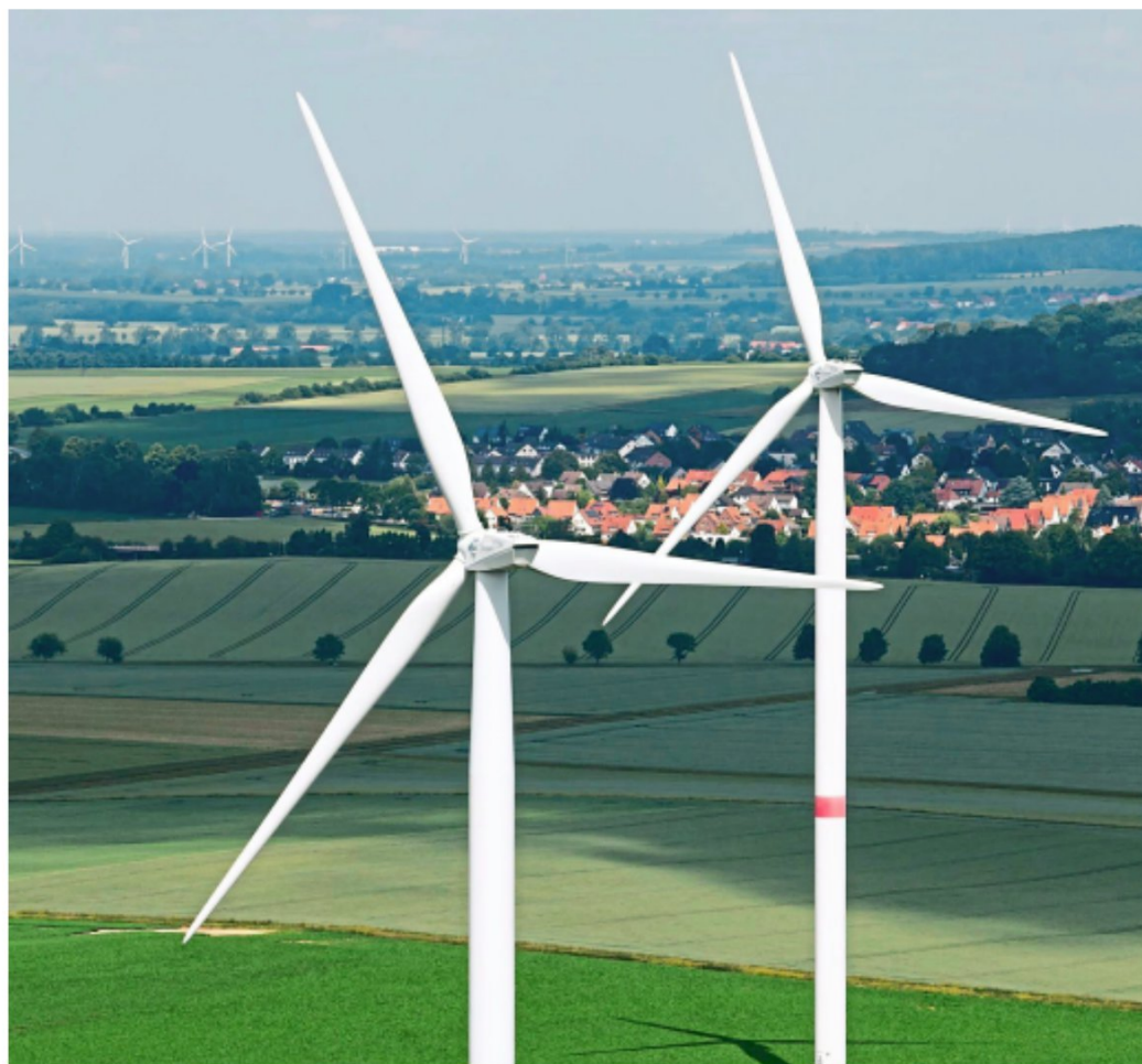
In der Stadt Dülmen schreitet der Ausbau der Windenergie voran (Symbolbild).
