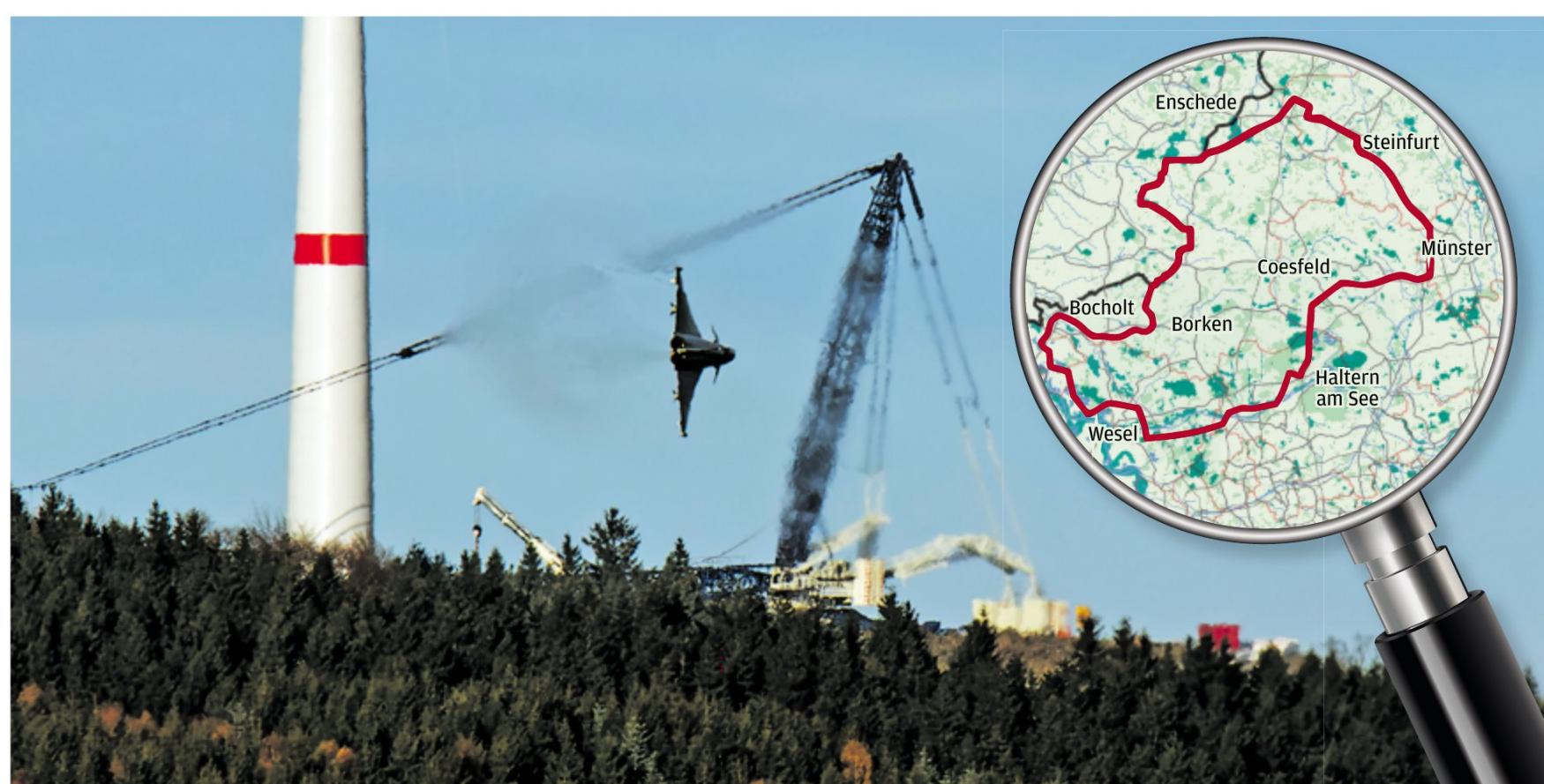
Ein Kampffjet dreht im Sauerland im Tiefflug vor einer Windradbaustelle ab.
