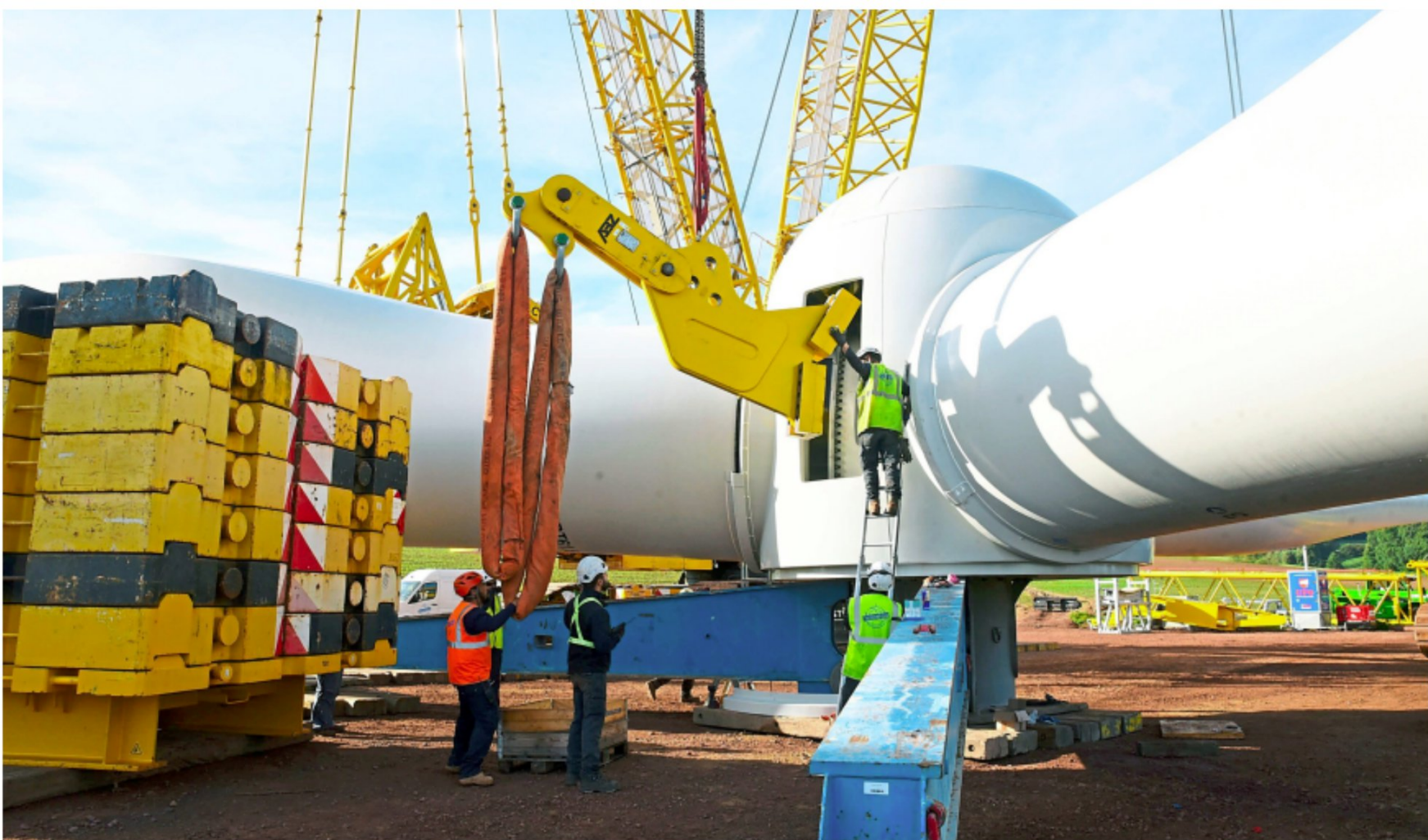
Die Windradnabe mit den drei Rotorblättern wiegt fast 102 Tonnen. Arbeiter schrauben eine Halterung (gelb), an der ein Kran den Rotor in die Höhe ziehen wird.
